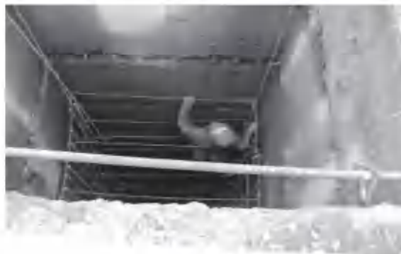
人工挖孔桩施工
