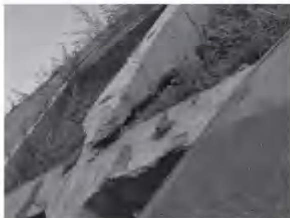
格构钢筋设置问题
