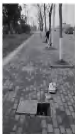
电磁感应直接法探测天然气管道
