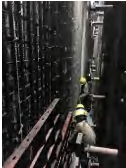
(b) 侧墙模板拼缝与千斤顶对应
