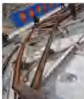
1-2 边部钢桁架直端拱制作
