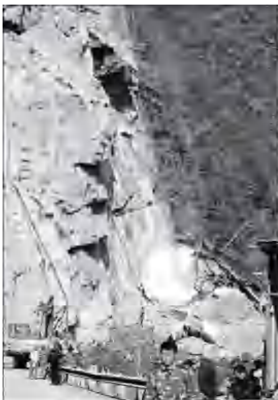
宜万铁路隧道出口岩崩事故
