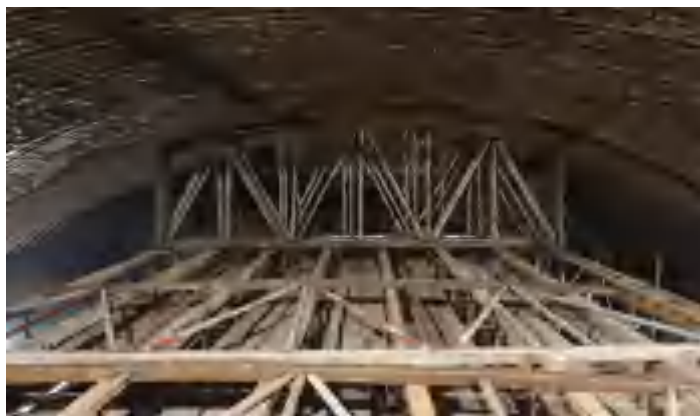
(b) 拱部中段位置钢桁架与千斤顶方木组成受力体系
