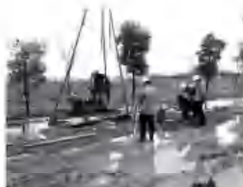
跨孔超声波探测现场
