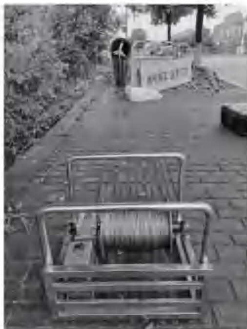
管道三维姿态测量非金属天然气管道现场
