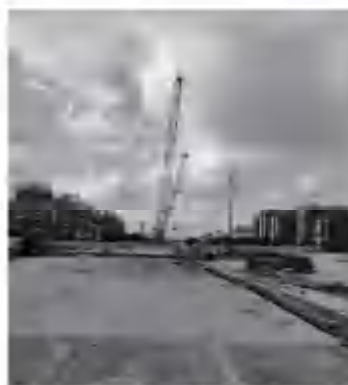
轨道交通基坑未开挖
