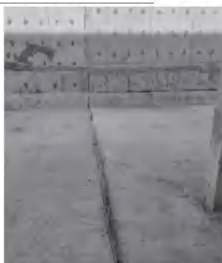
伸缩缝设置不符合设计要求
