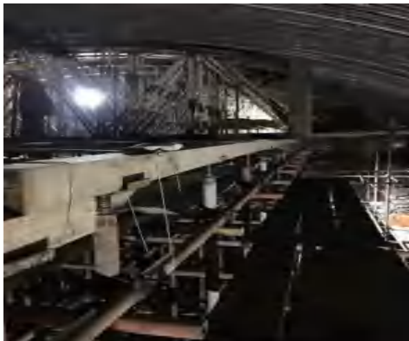
(a) 拱部中段位置钢桁架与千斤顶方木组成受力体系
