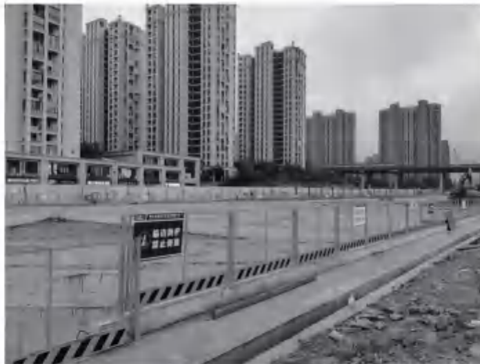
明挖基坑(开挖与回填)监测
