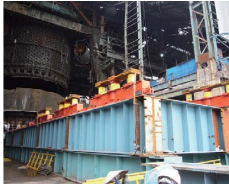
钢厂高炉安装同步顶升
