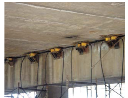
桥梁同步顶升
