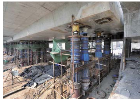
桥梁同步顶升
