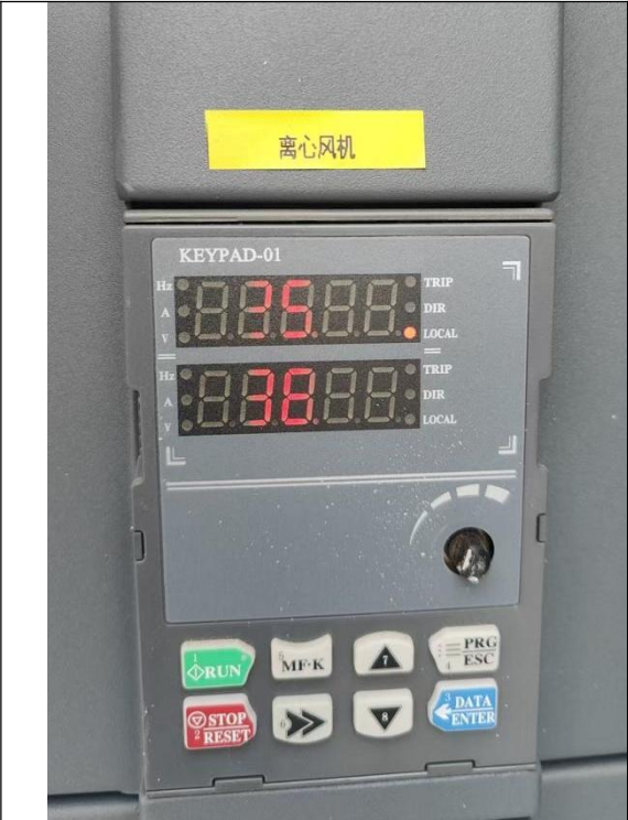
风机维持频率（38HZ）
