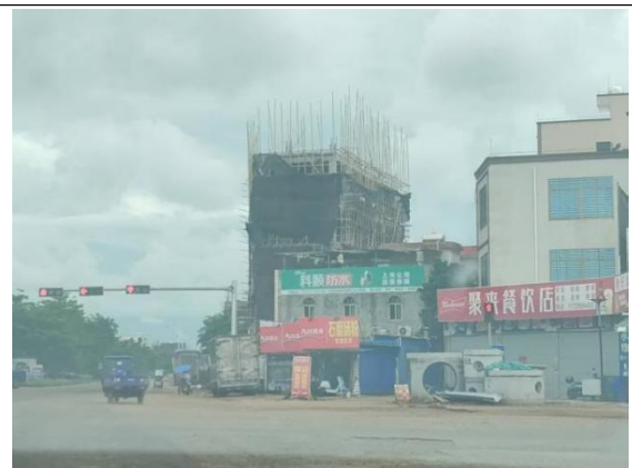
正在建设居民楼
