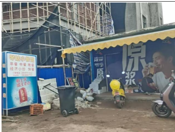
正在建设居民楼
