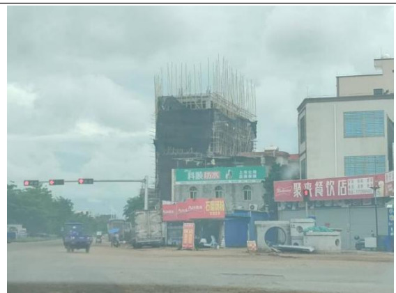
正在建设居民楼
