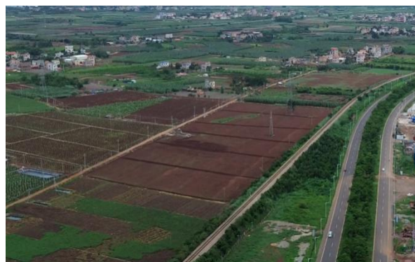
1#施工临建区区域已复耕
