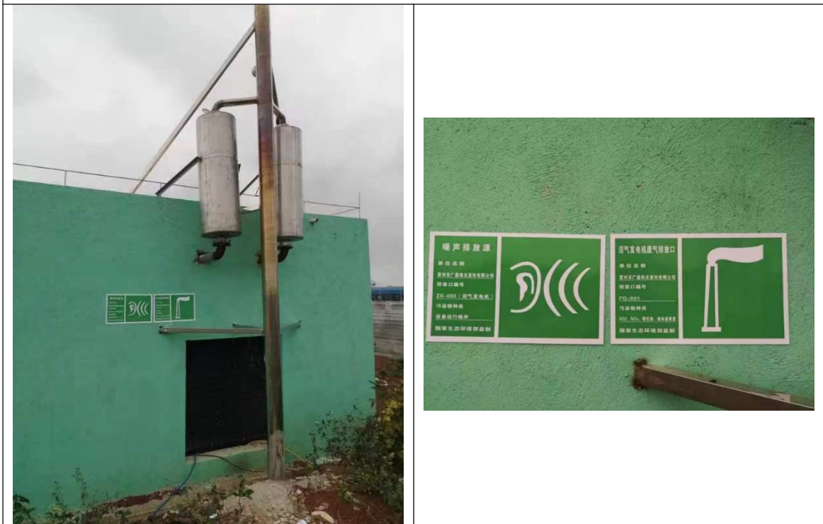
废气排放口标志牌设置图片 (FQ-01)
