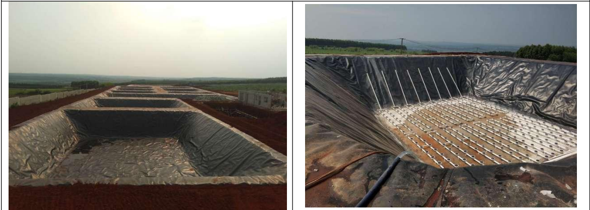
污水处理设施施工期防渗措施照片
