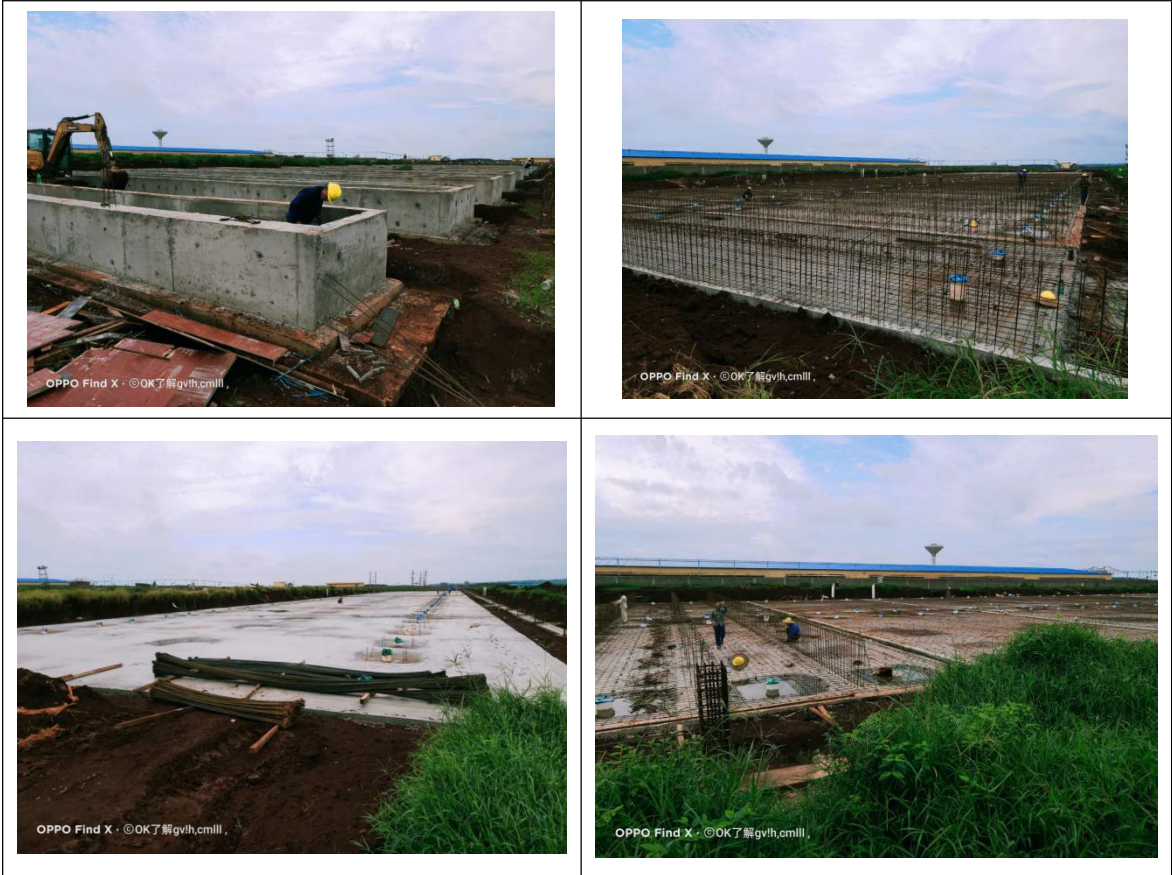
猪舍施工期防渗措施照片
