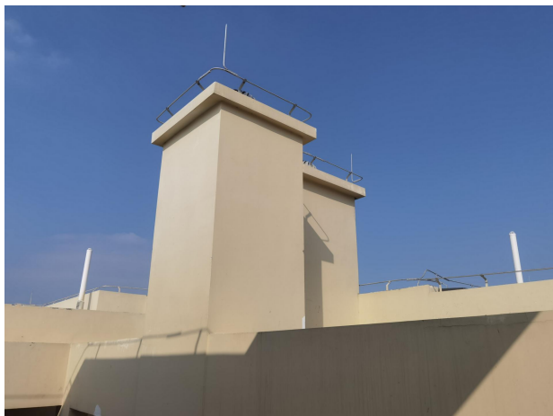
住宅楼厨房烟道排气口
