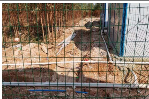
图6-4 施工营地排水沟
