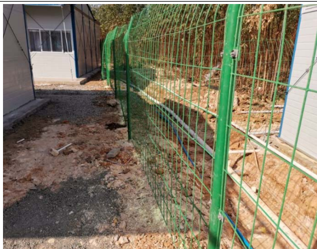
图6-3 施工区域排水沟
