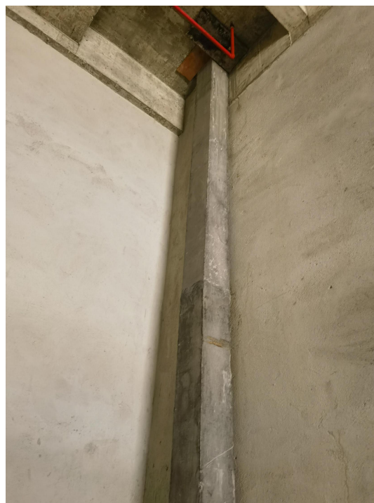
商铺烟道排气口
