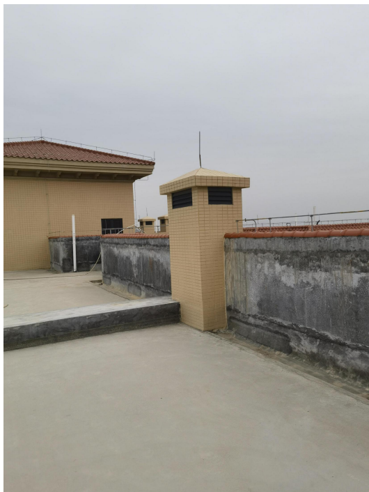
住宅楼厨房烟道排气口
