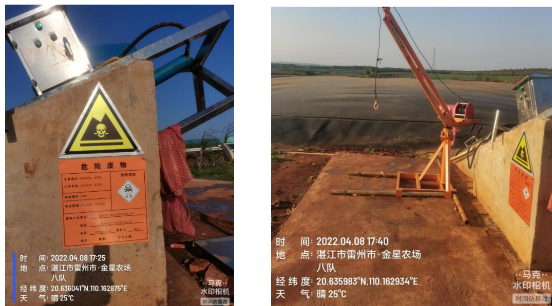
危险废物储存间 GF-02
