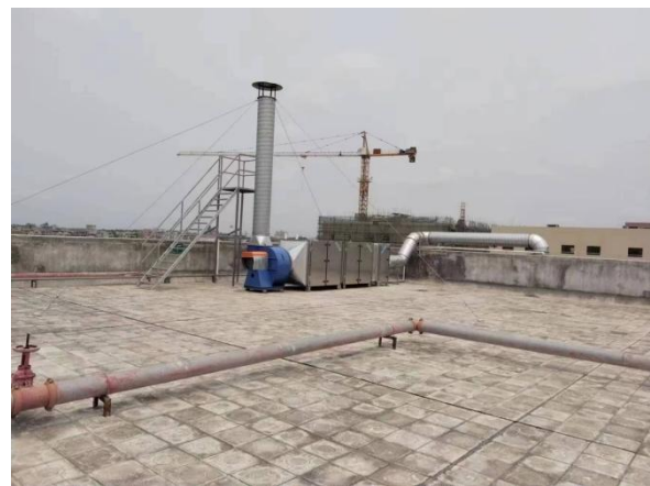
注塑区废气收集管道
