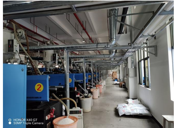
注塑区废气收集管道
