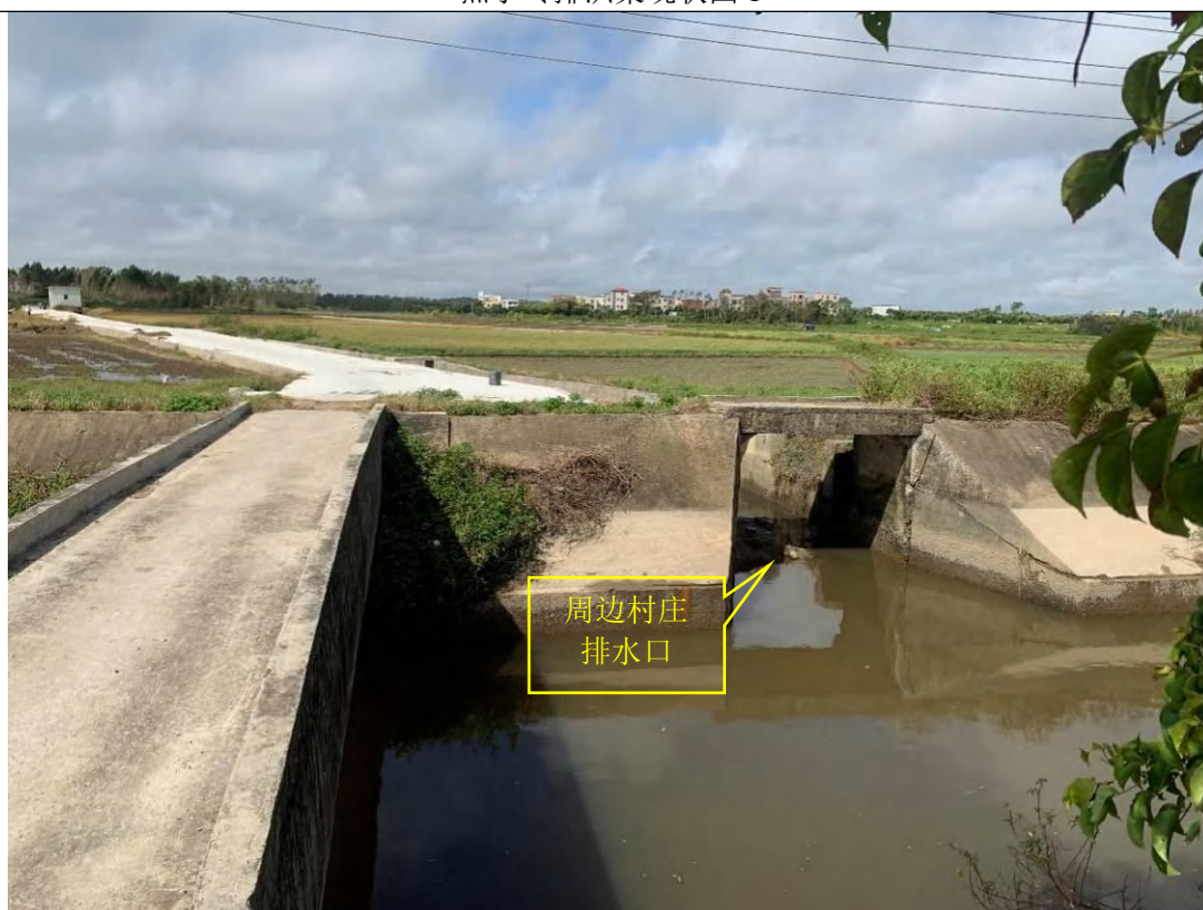
蕉子岭排洪渠现状图 2
