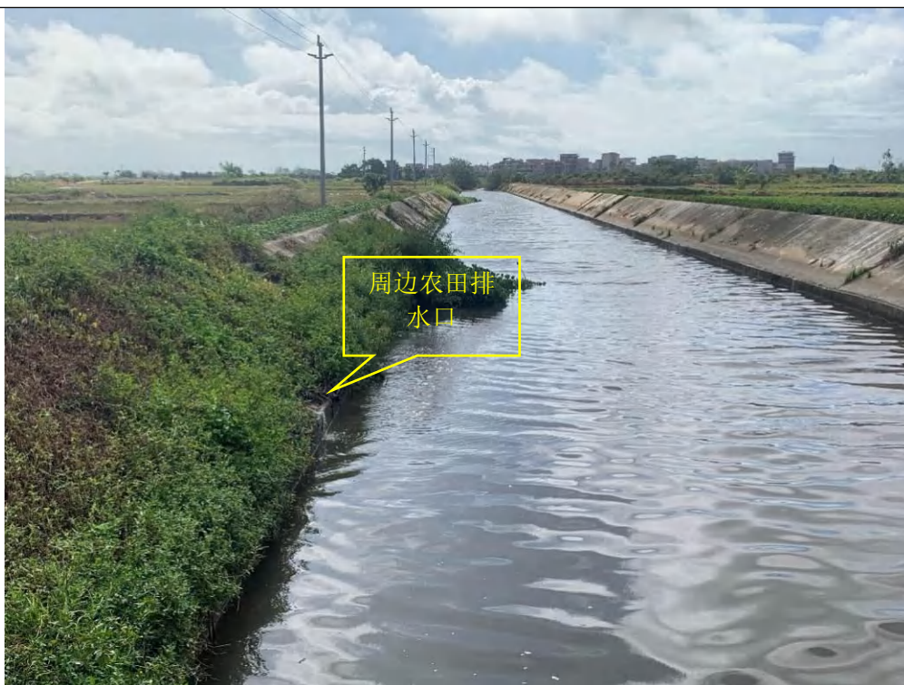
蕉子岭排洪渠现状图 1
