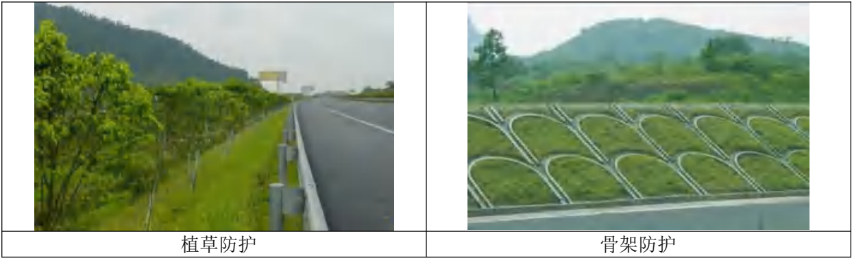
图3.2-8 路堤边坡防护
