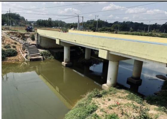
K16+320 桥梁现状
