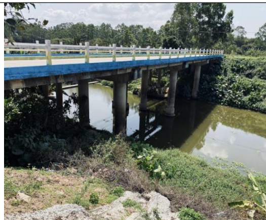
K13+815 桥梁现状
