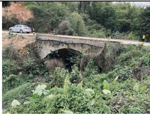
K4+050 桥梁现状
