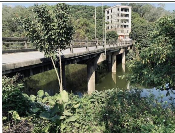
K0+150 桥梁现状
