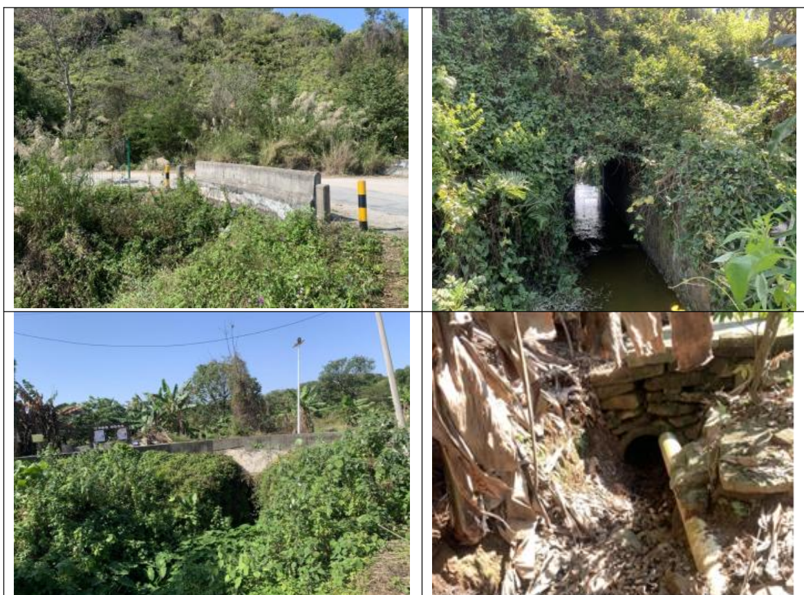
图 2-2 沿线部分涵洞现状图
