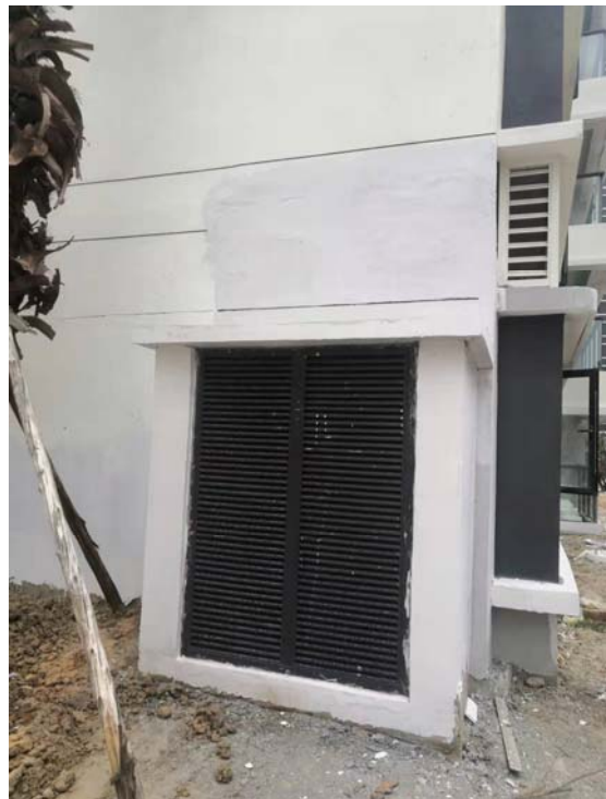
图 6-6 地下室排气口
