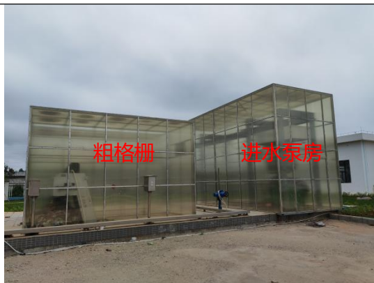
粗格栅、进水泵房
