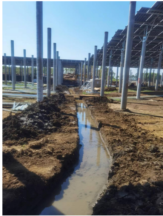
施工区域沉淀沟
