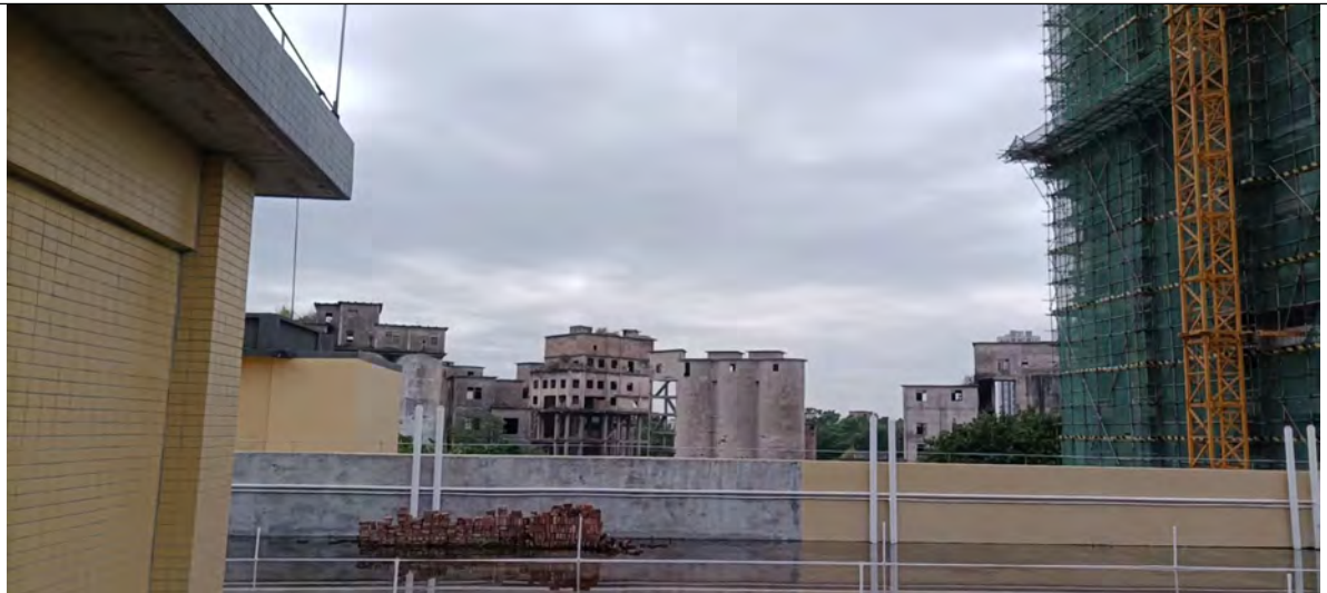
项目南侧 5m 龙振水泥厂
