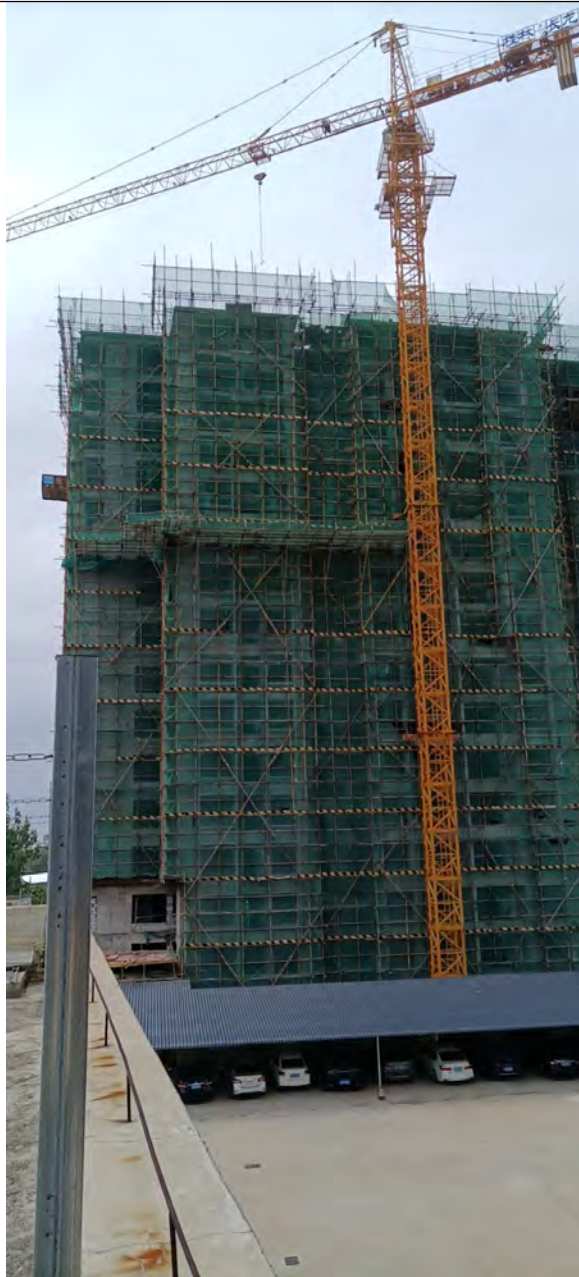
项目西侧相邻的房地产工地
