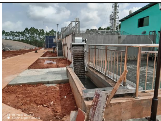
机械格栅（在后续工作中已与集水池一起进行密闭处理，见右图）
