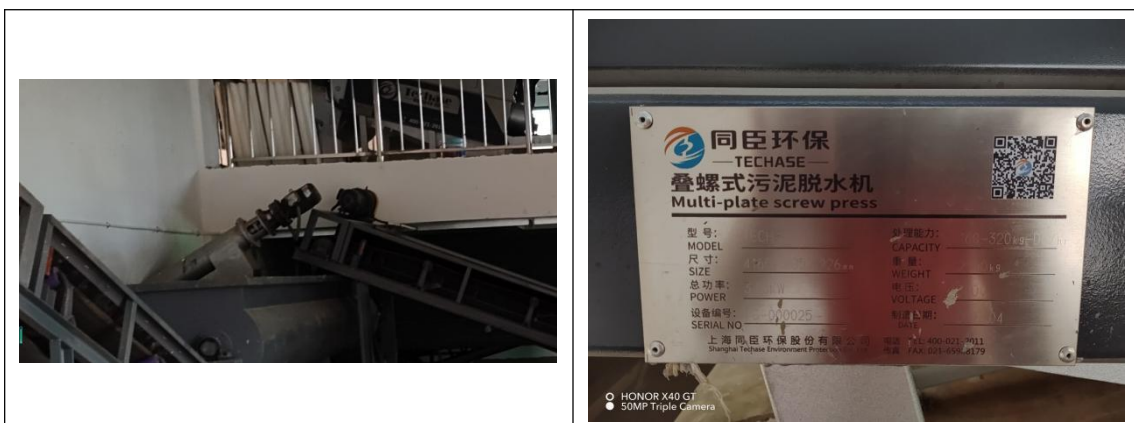
叠螺式污泥脱水机（1台）规格：160-320kg/h，N=4.5kw，厂家：上海同臣
