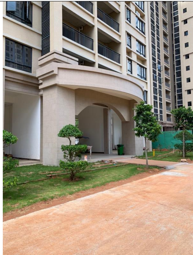
图6-1 项目主楼正面
