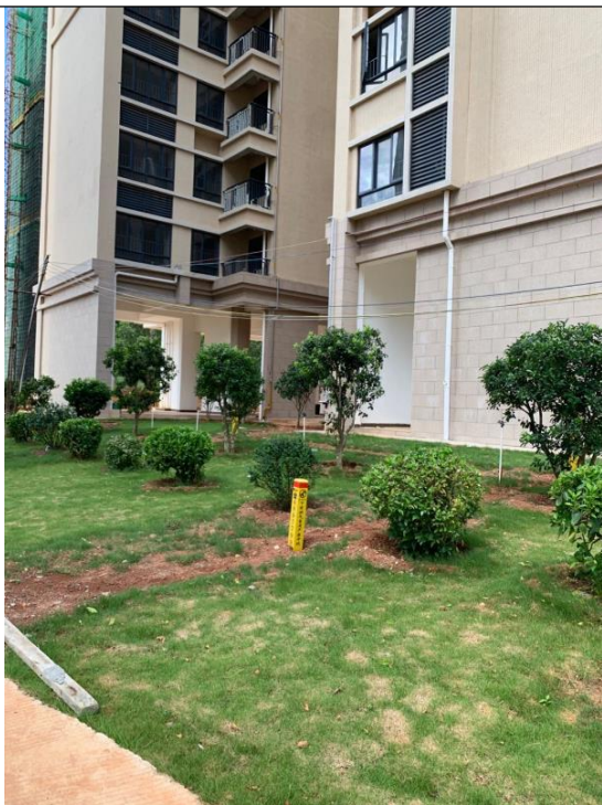
图6-3 项目西侧道路及绿化
