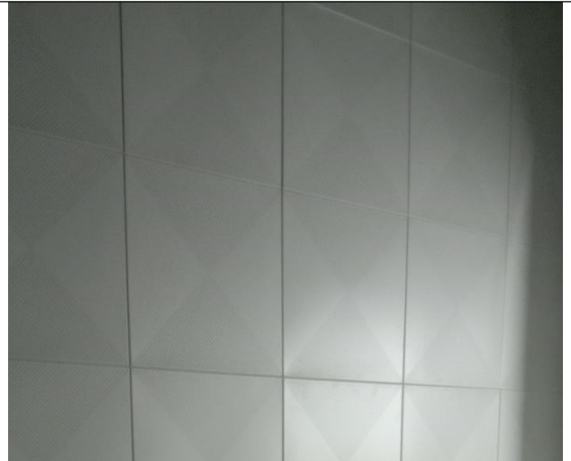
图6-14 备用发电房消声墙
