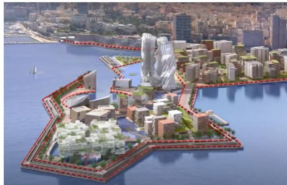
目前正在建造的混凝土墙，设计使用年限至少100年，能将对海洋生物的影响降至最低。
