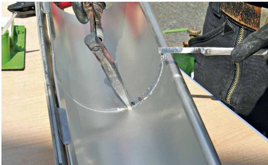
不锈钢锡焊并不难，但需要专用助焊剂。© BRANDT Edeltahldach GmbH
