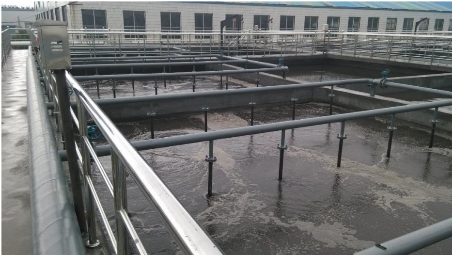
图 5.2-3 多级 A/O 反应池工程应用图
