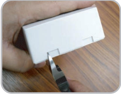
3.使用切割机切割电缆出口的侧
