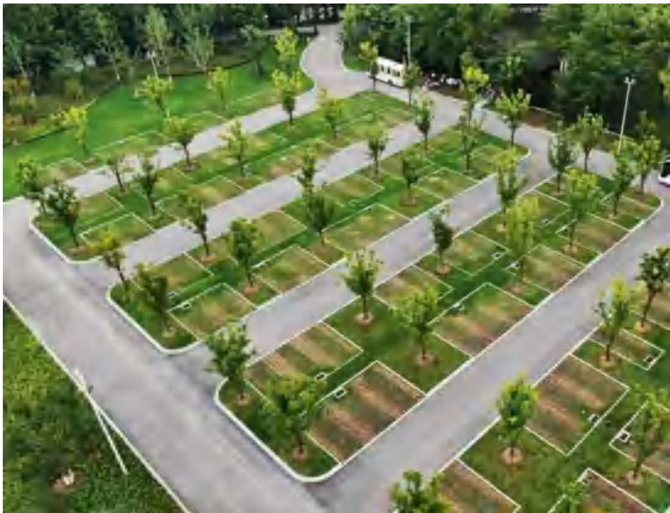
图E3-2 停车场透水性铺装
