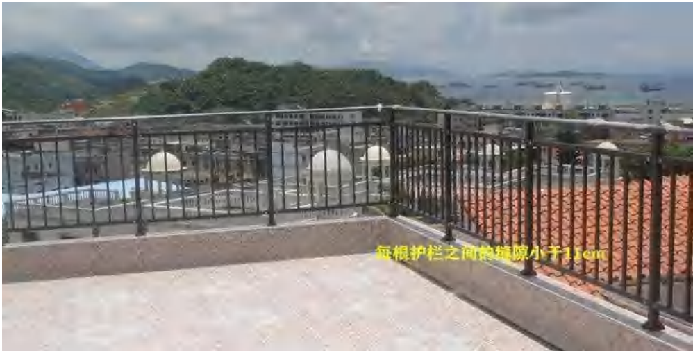
图A12-1 防护栏杆构造示意图
