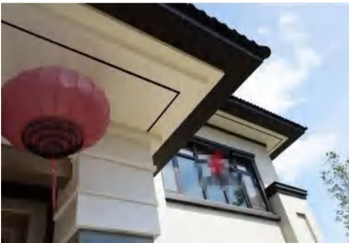
屋檐遮阳设施
