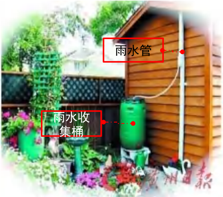
简易的家庭集雨罐，分流器依靠手动控制
