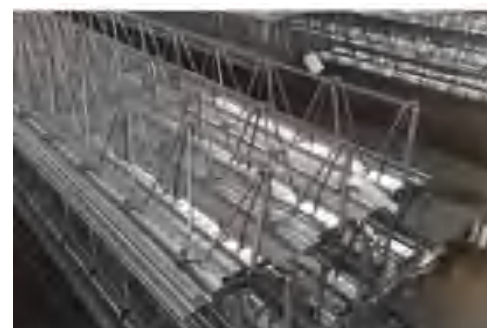
钢筋桁架楼承板
