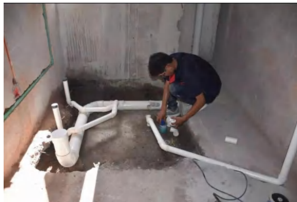
厨房间废水管和卫生间的污水管道安装
