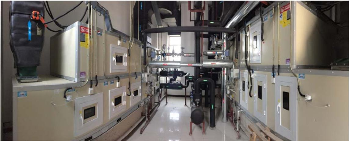
本项目于 2014 年完工，自控系统设计 500 点，采用 iGE-5000 v6.5 净化空调自控系统，系统目前运行良好。
