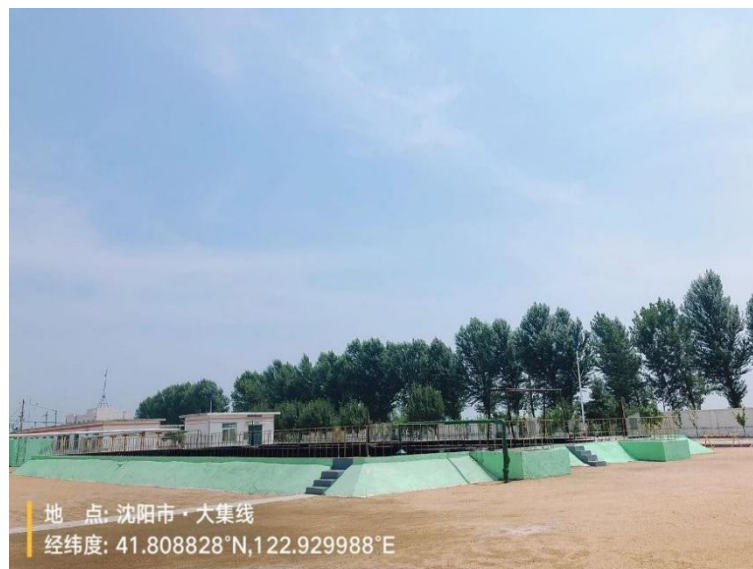
图 2-5 危废暂存区域照片
