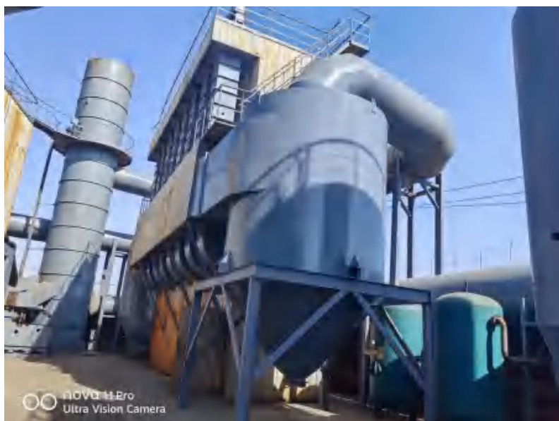
熔炼炉的旋风+布袋除尘器
