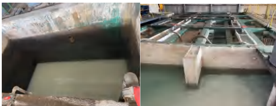
1000 \text{m}^3/\text{d} 污水处理站中和池、沉淀池
