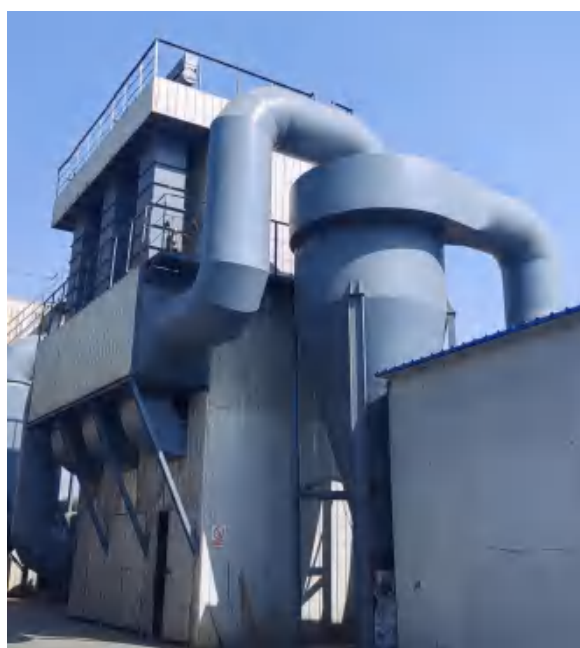
铝灰分离机的旋风+布袋除尘器
