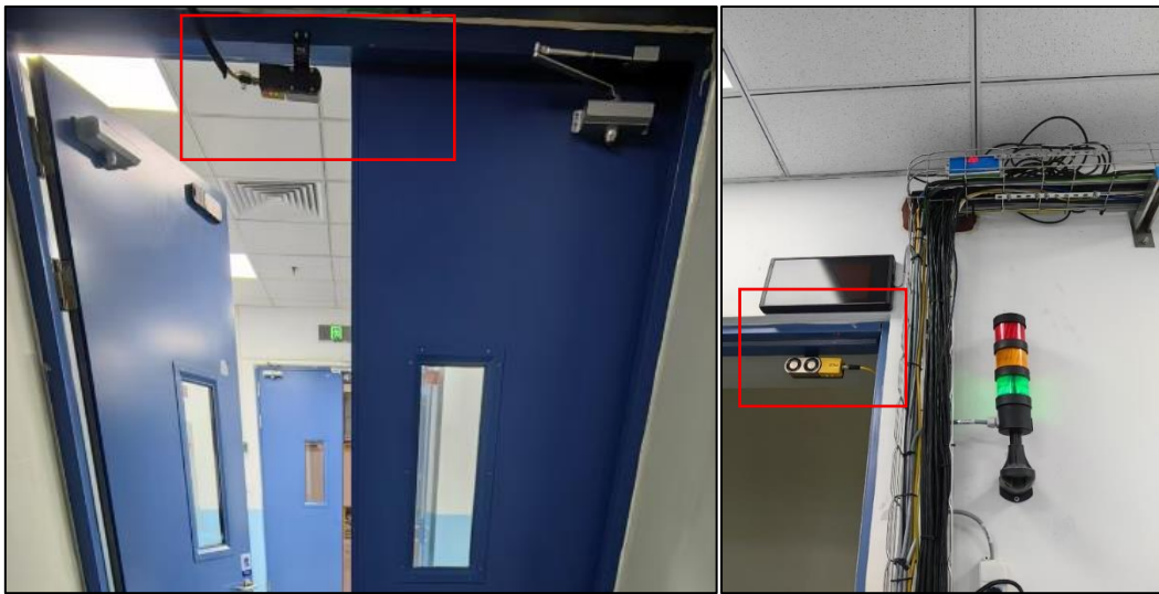
图 3-6 门机联锁装置
