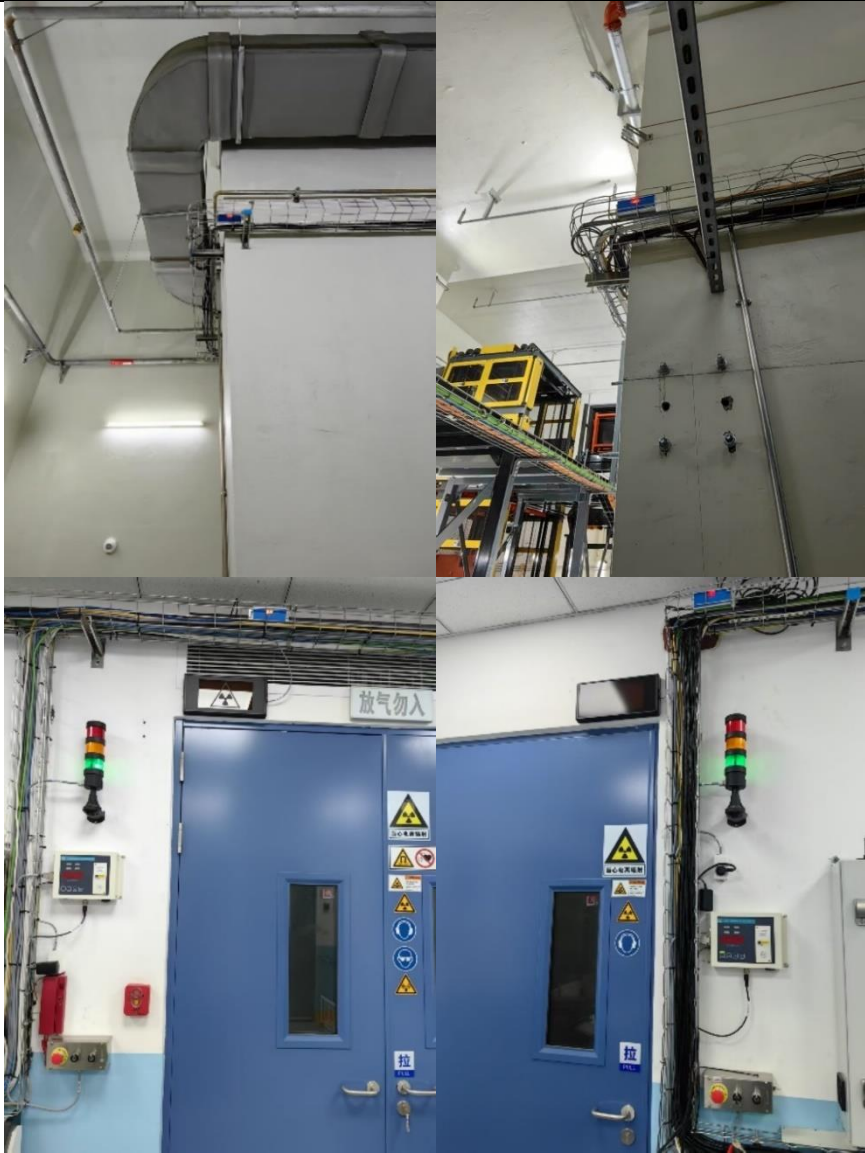
图 3-12 剂量探头及剂量联锁
