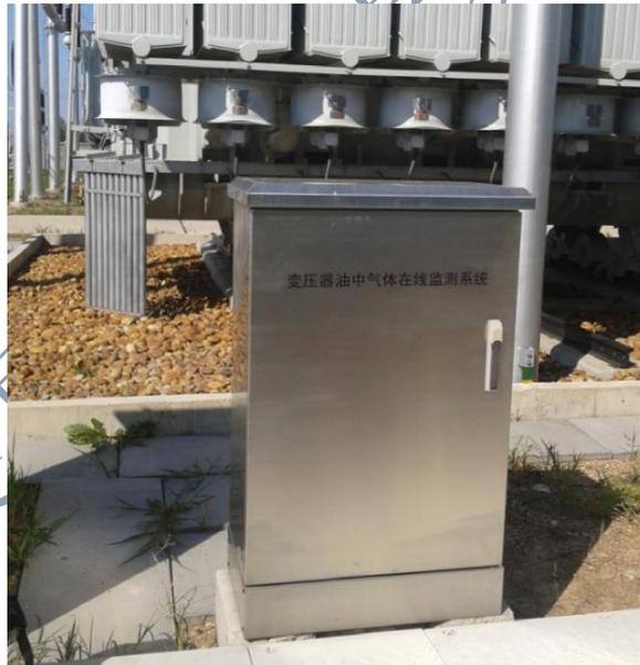
每台油色谱就地柜有 1 根电源进线、1 根通讯线(根据现场情况也可走光纤)、1 根进油管、1 根回油管、1 根铁芯传感器信号及电源线, 它们都需要波纹管或者镀锌管保护。
