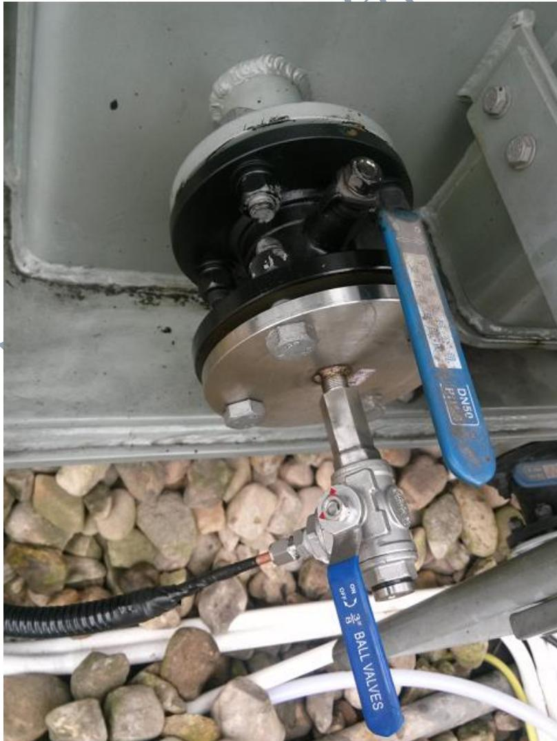
油管的连接由油色谱厂家在工作负责人的监督下完成，工作有：取油阀、回油阀的安装及与油管的连接，油管与现场油色谱就地柜的连接，油管排空。取油阀、回油阀的安装过程中会有少量的变压器油损失，油管的排空会有少量的变压器油损失，损失的油不影响变压器的运行。
