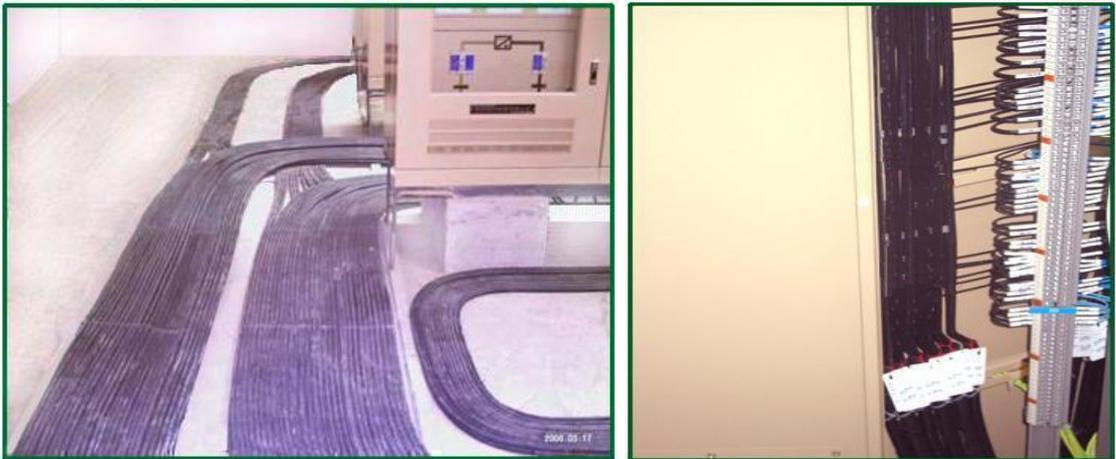
工质量是 关键。封堵时先使用 II 型防火封堵材料包紧电缆，再使用 I 型防火封堵材料填满预留孔，并与地面抹平。
