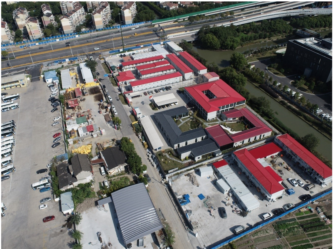
施工生产生活区
