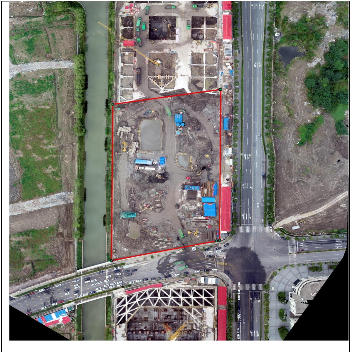
附图 5-1 项目区影像照片（施工中 2021 年 10 月）
