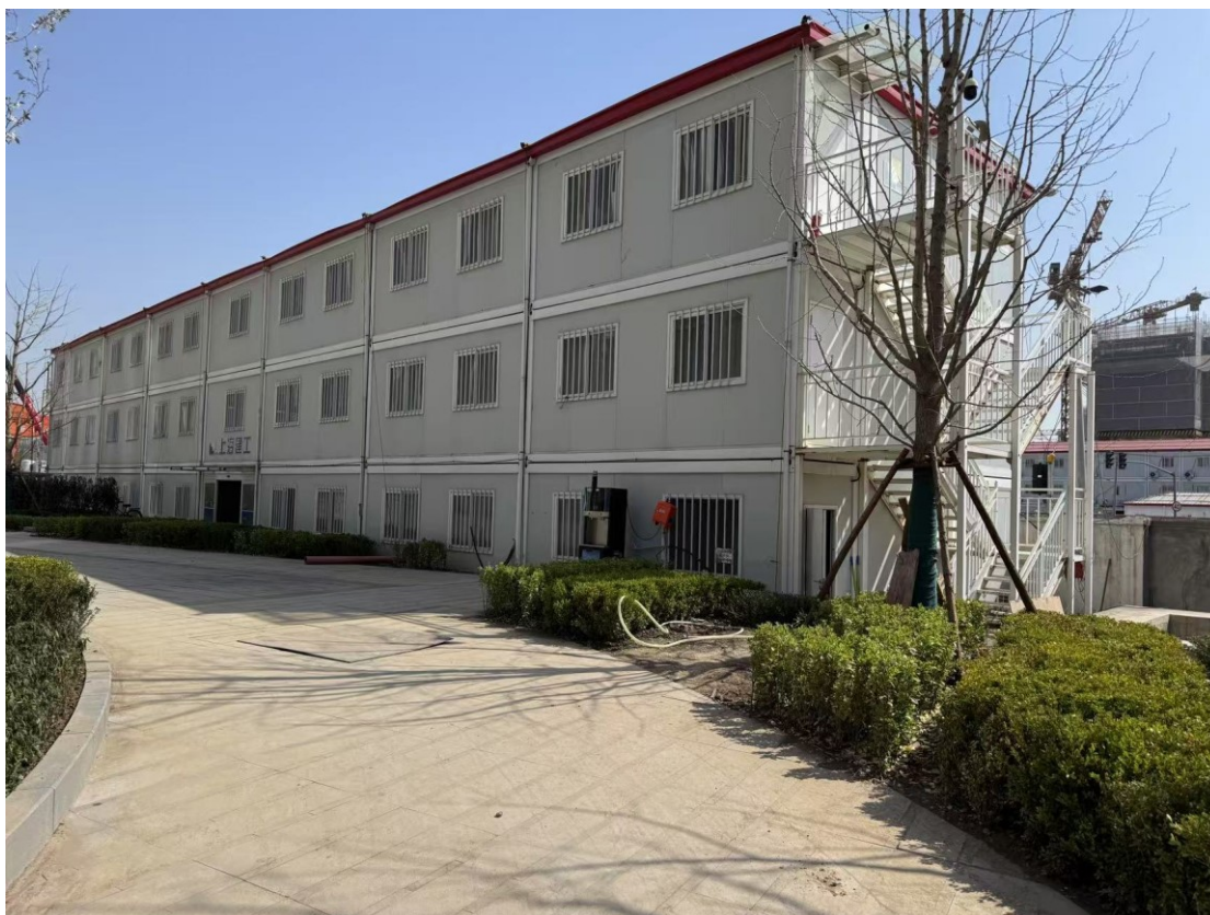
图 3.1-1 施工生产办公区
