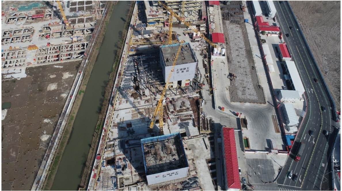
附图 5-2 项目区影像照片（施工中 2023 年 3 月）
