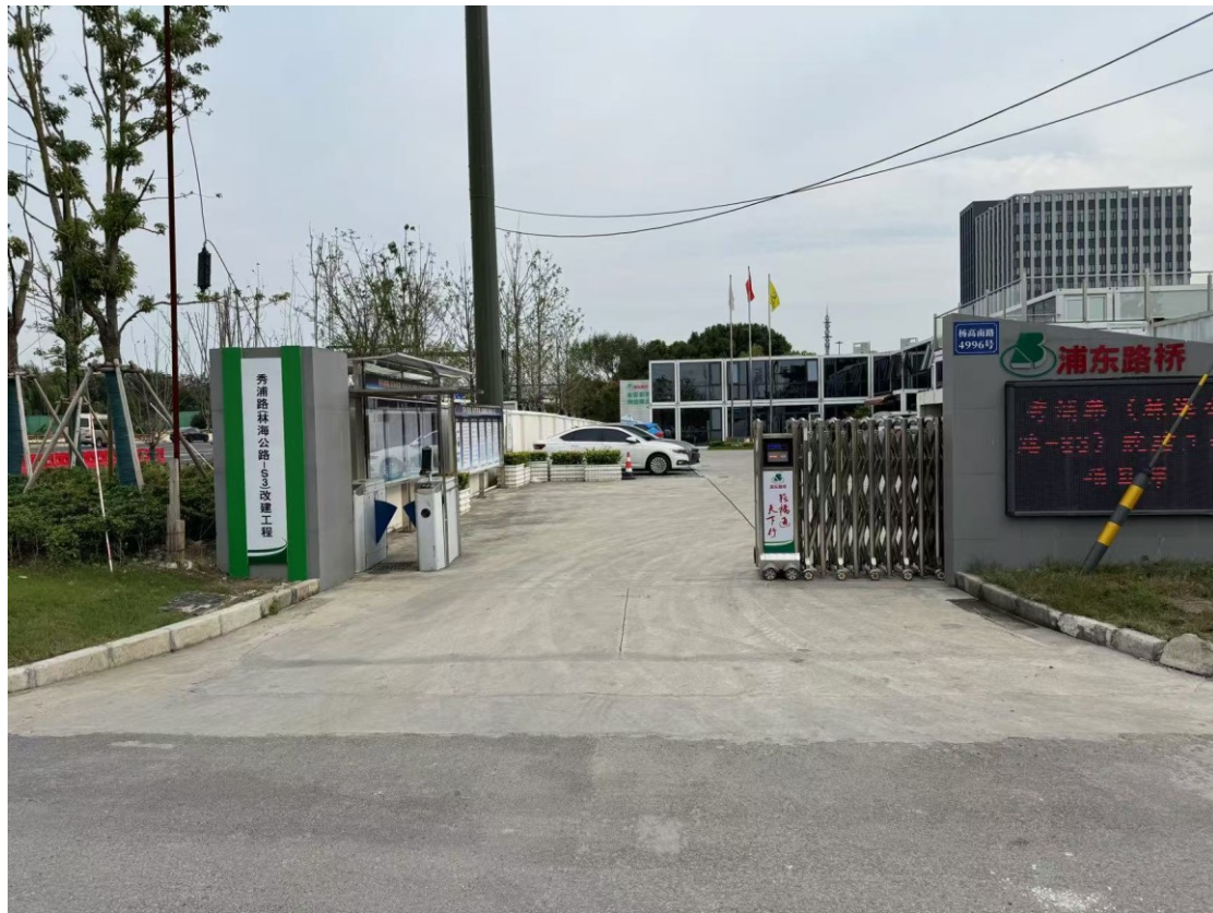
图3.1-1 施工生产生活区现状（2024年12月）
