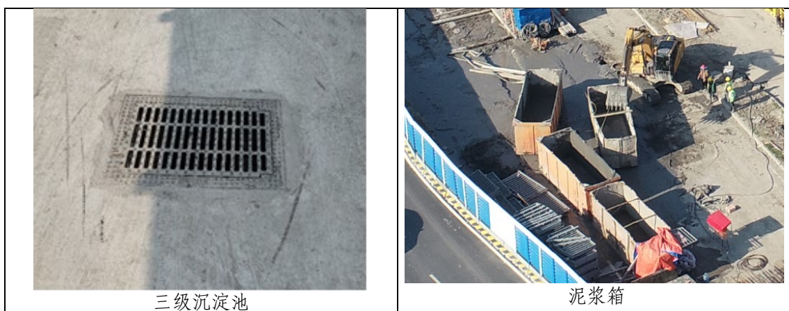
图4.3-1 临时措施实施情况
