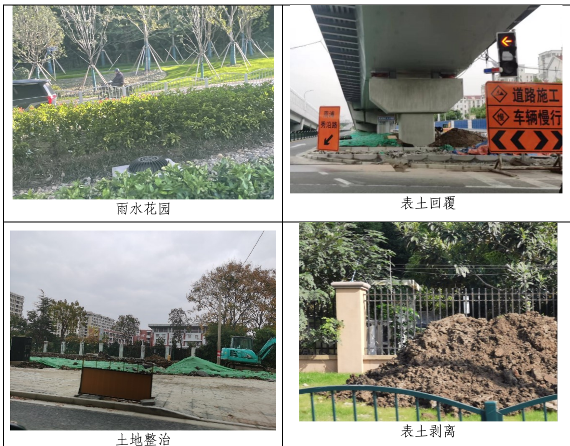
图4.1-1 工程措施实施情况
