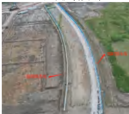
海洋五路临时排水沟
