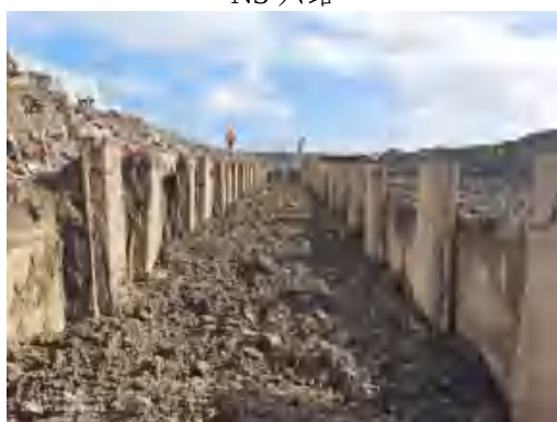
土方开挖、堆放
