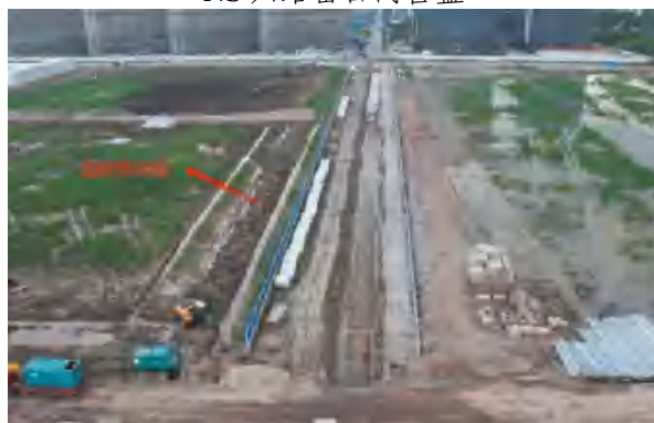
NS 一路临时排水沟
