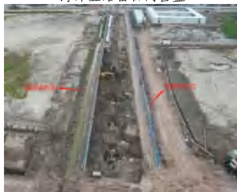
NS 五路临时排水沟
