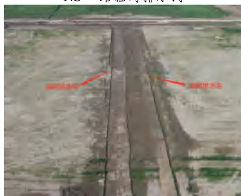
NS 六路临时排水沟
