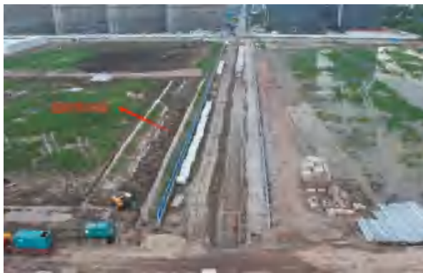
NS 一路临时排水沟
