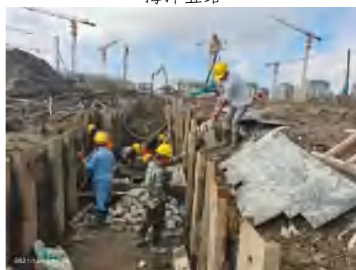
土方开挖、堆放
