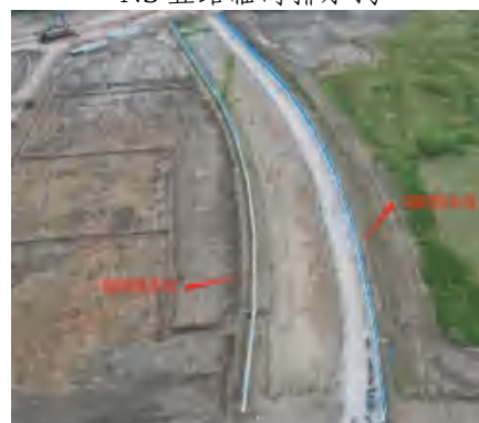
海洋五路临时排水沟
