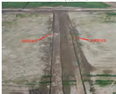
NS 六路临时排水沟
