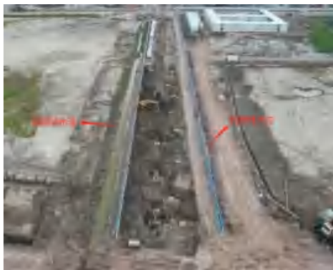
NS 五路临时排水沟
