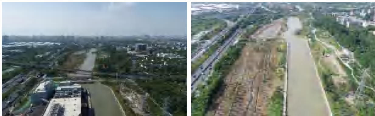
现场航拍图（5月）
