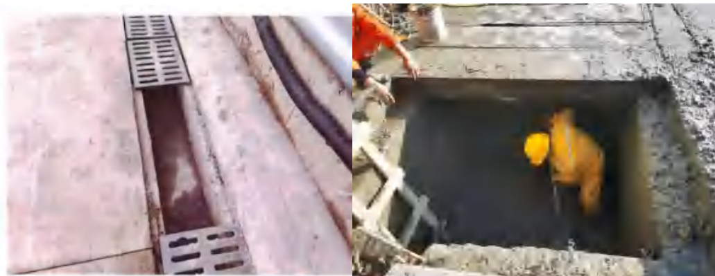
图 1 现场临时措施情况
