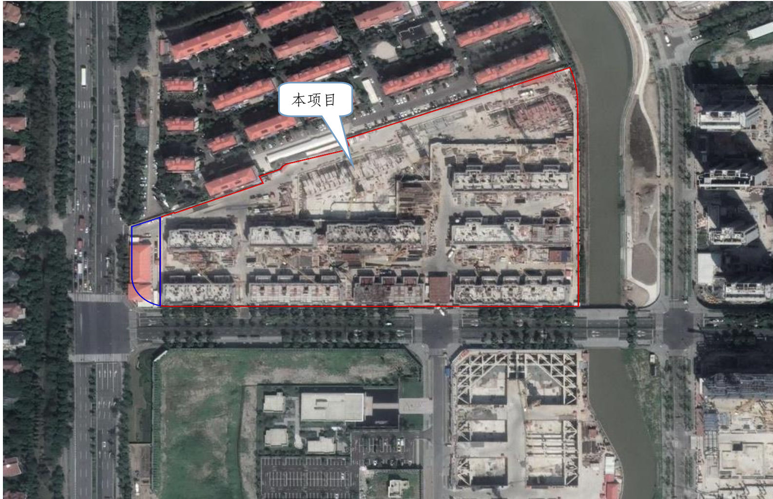
附图 4-2 项目区影像照片（施工中 2021 年 9 月）
