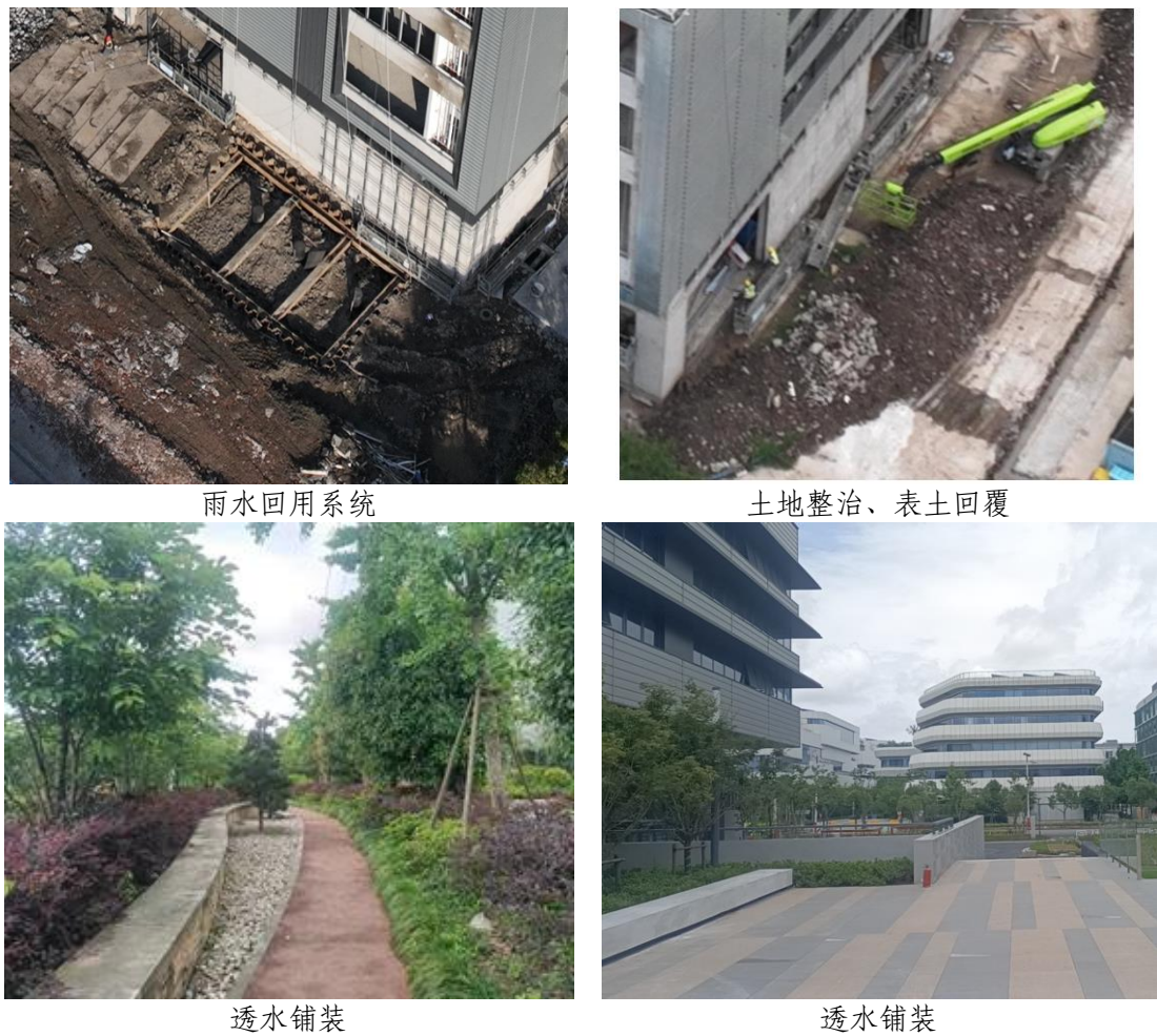
图4.1-1 工程措施实施情况
