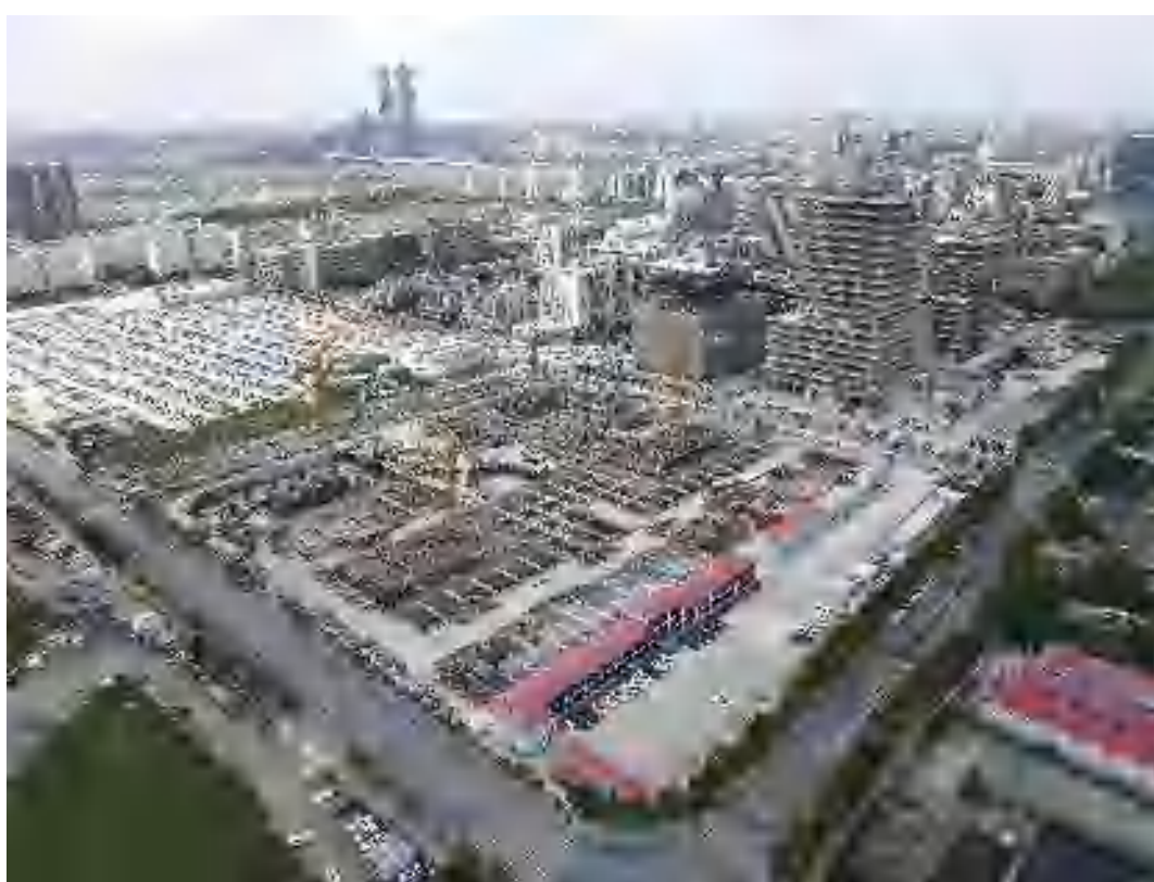
2022 年9月 工程 建设 中期 遥感 影像
