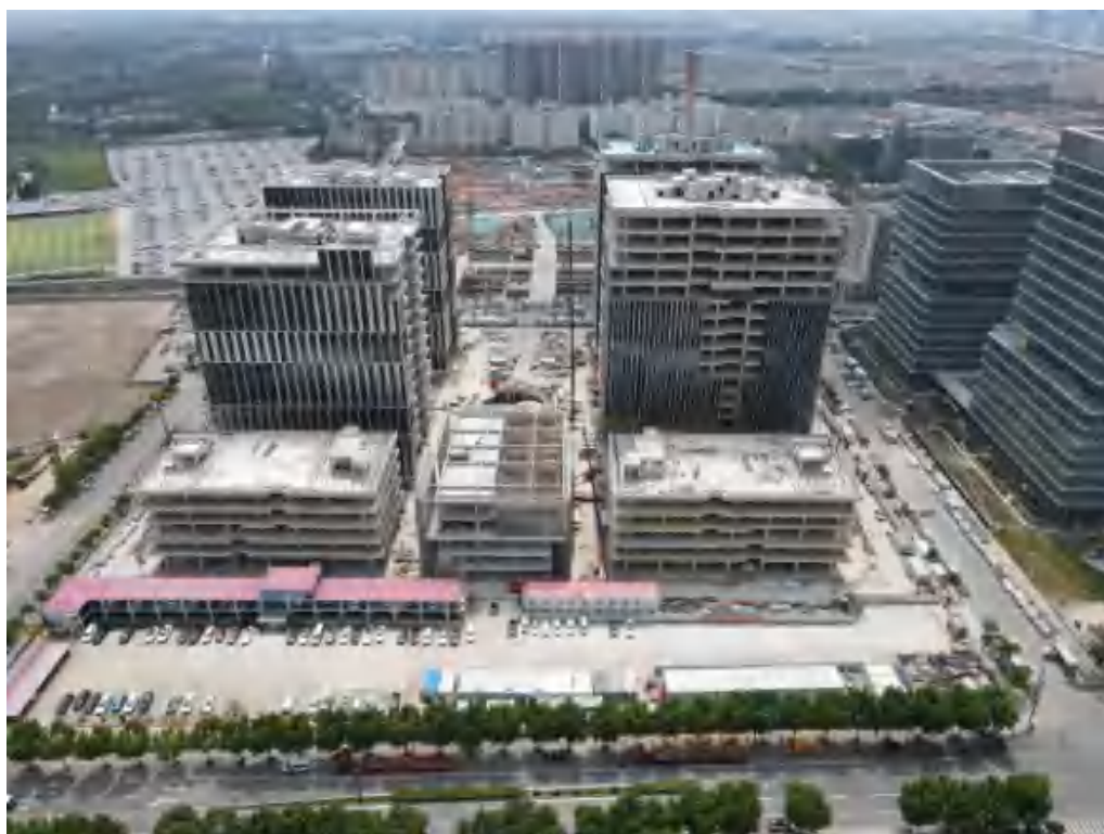
2023 年9月 工程 建设 中期 遥感 影像
