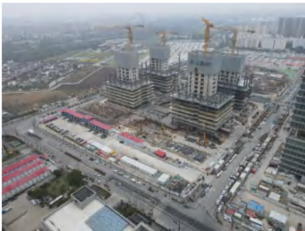
2023 年1月 工程 建设 中期 遥感 影像
