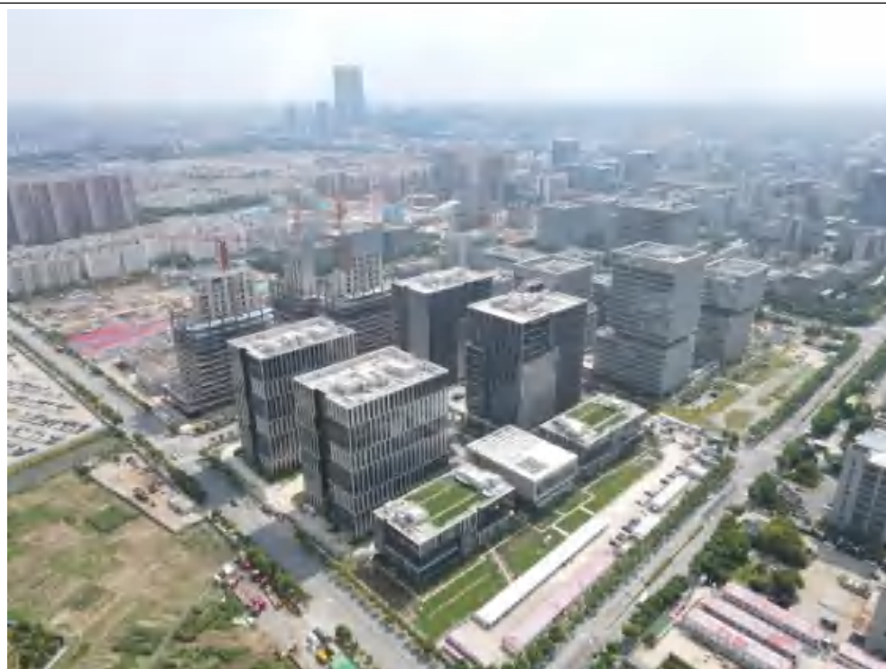
2024 年1月 工程 建设 中期 遥感 影像
