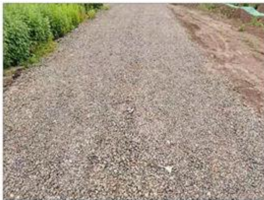
图 2.2-5 项目施工便道现状
