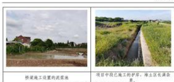
图 2.6-1 项目施工现状 (2021.7)
