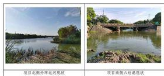
图 2.2-1 项目南北连接的河道现状
