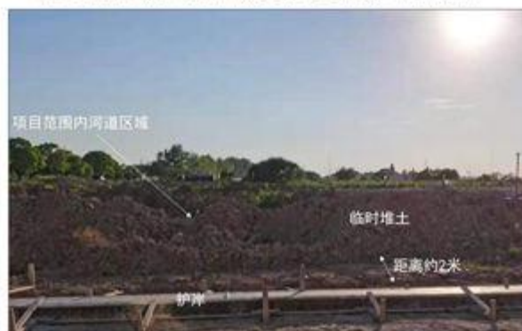
图 2.2-6 临时堆土区设置（堆土为护岸开挖土方，计划回填护岸基筑）
