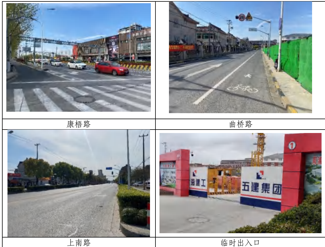
图 1.2-2 项目紧邻道路
