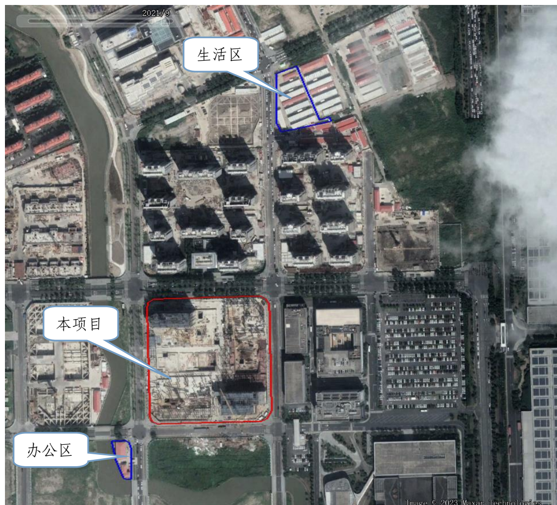
附图 4-2 项目区影像照片（施工中 2021 年 9 月）
