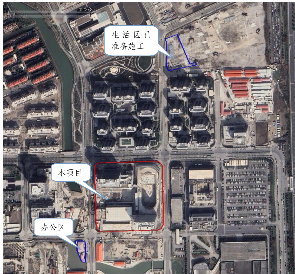
附图 4-3 项目区影像照片（施工中 2023 年 3 月）
