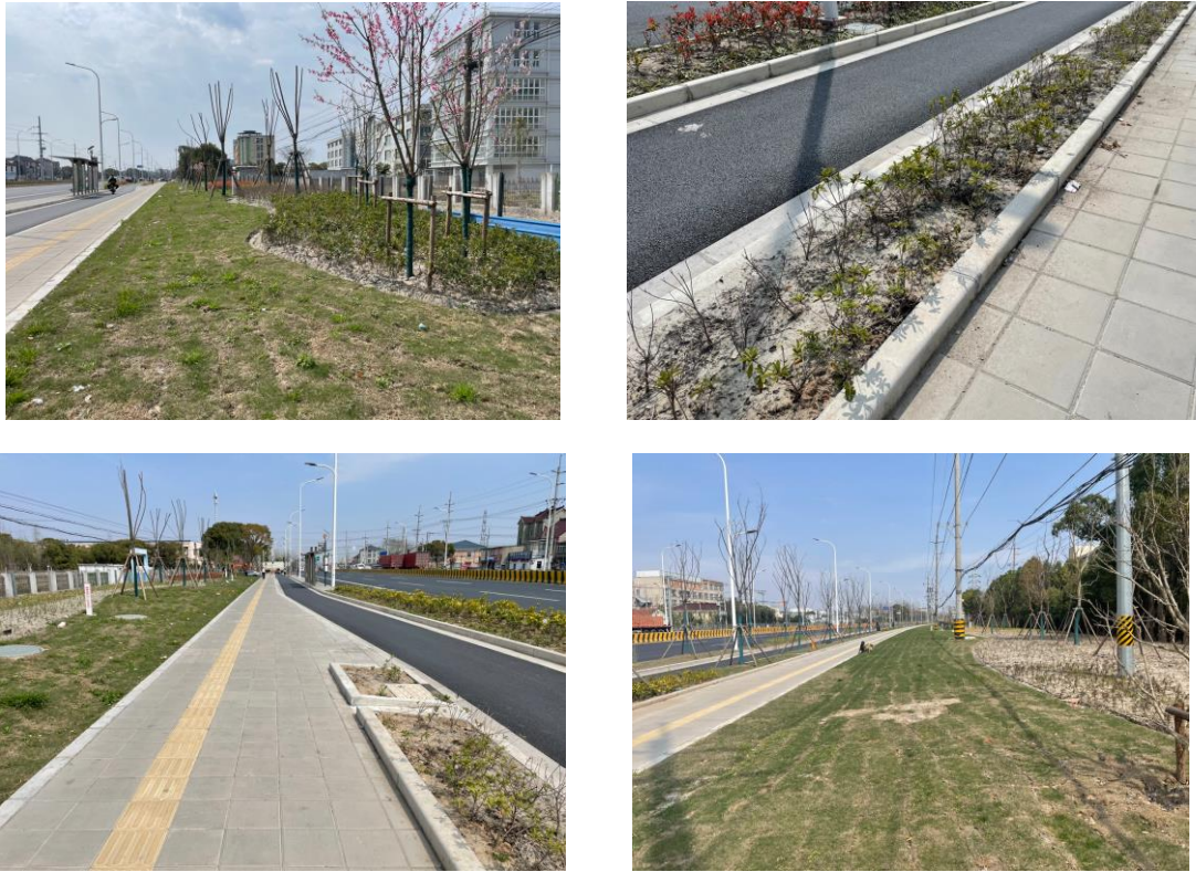
图4.2-2 植物措施实施情况（拍摄日期2024年5月）
