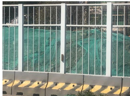
密目网苫盖（临时堆土区）
