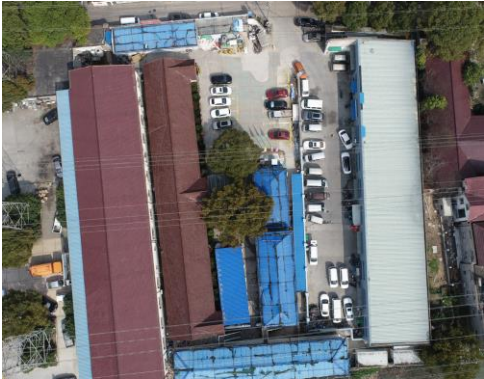
3 标大临（已于 2023 年硬地移交原单位， 现用作其他项目大临）
