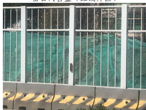
密目网苫盖（临时堆土区）
