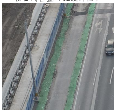
密目网苫盖（路基工程区）
