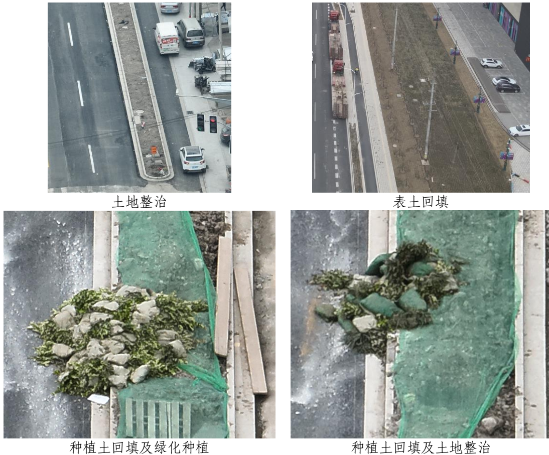
图4.2-1 工程措施实施情况
