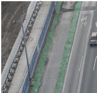
密目网苫盖（路基工程区）
