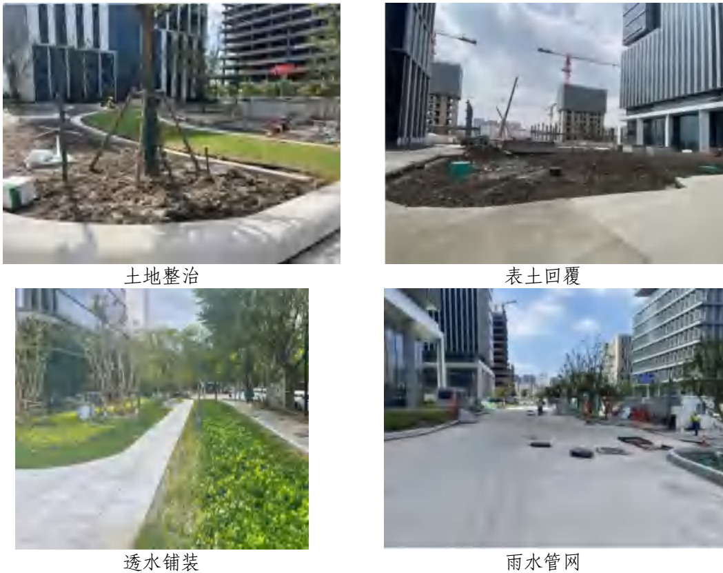
图3.5-1 工程措施实施情况
