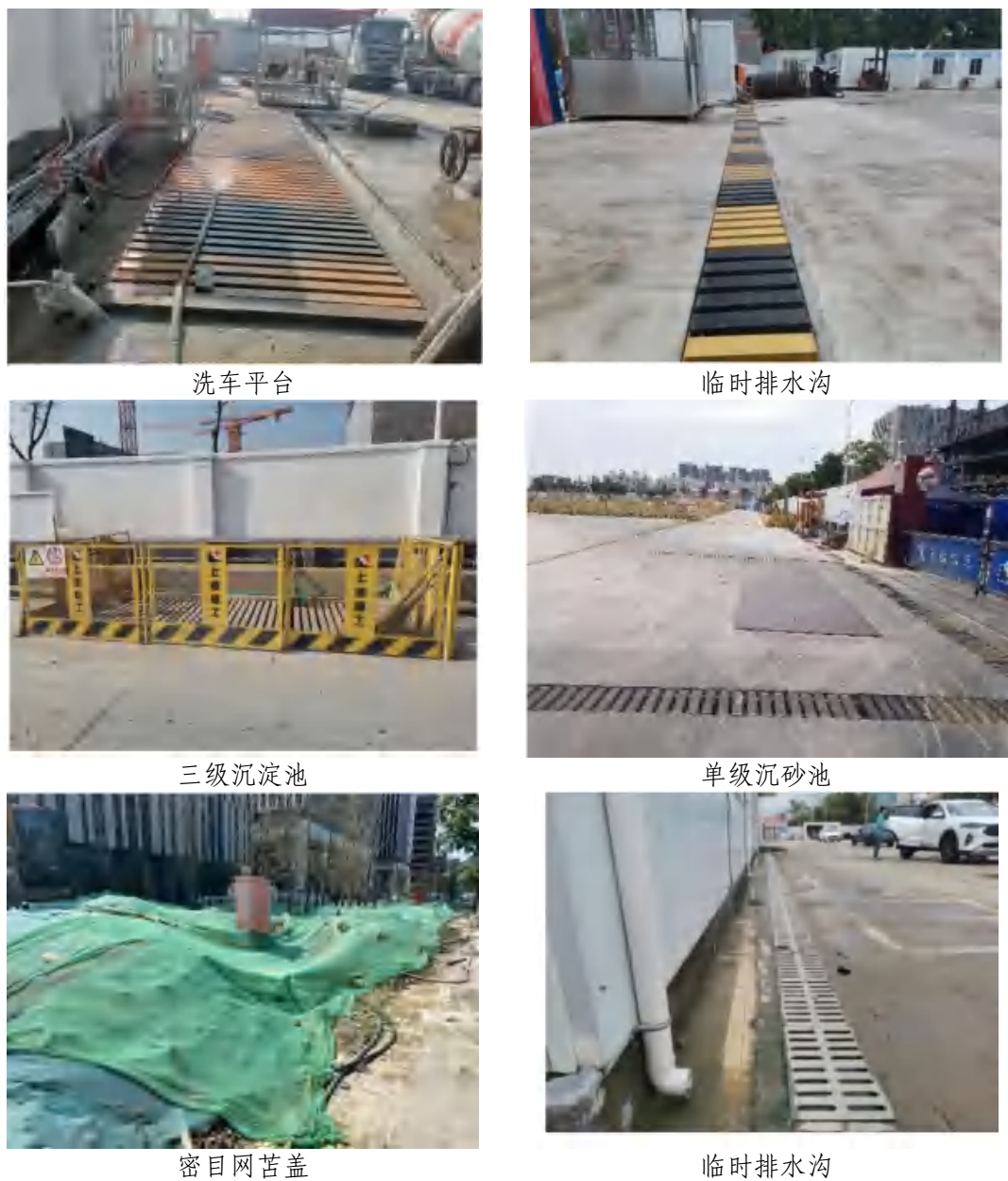
图3.5-3 临时措施实施情况
