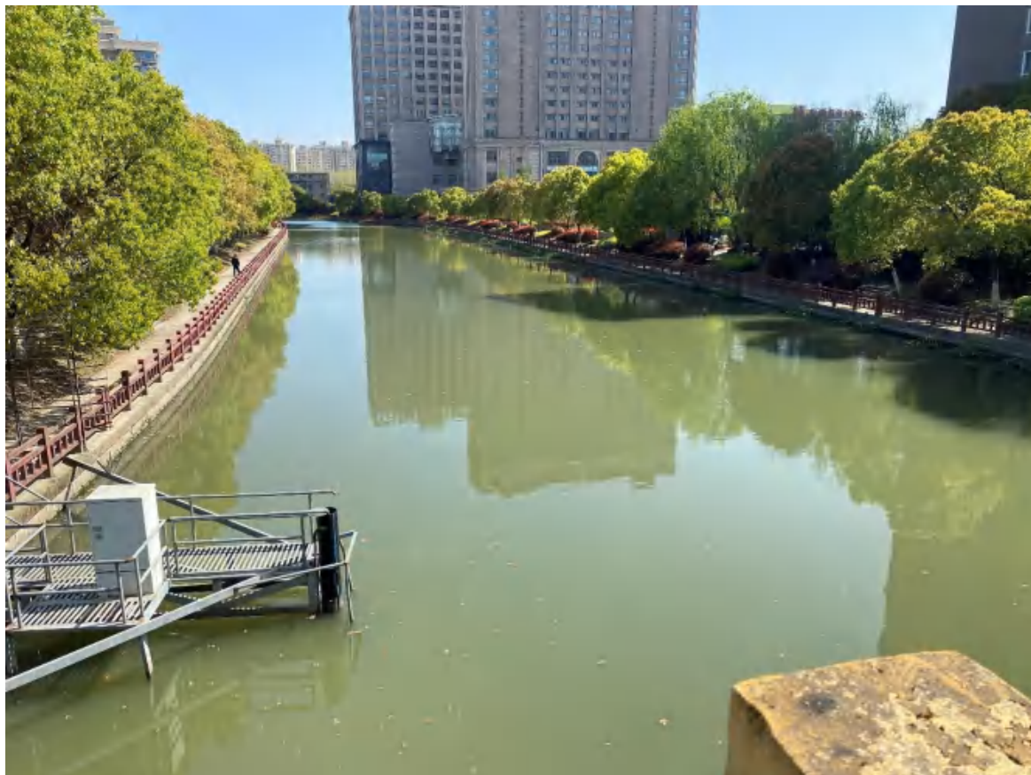
图 2.7-3 西侧咸塘港现状
