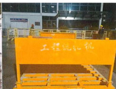
图 2 安装洗车平台
