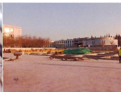
图 4 场地清理无泥浆，裸土已苫盖
