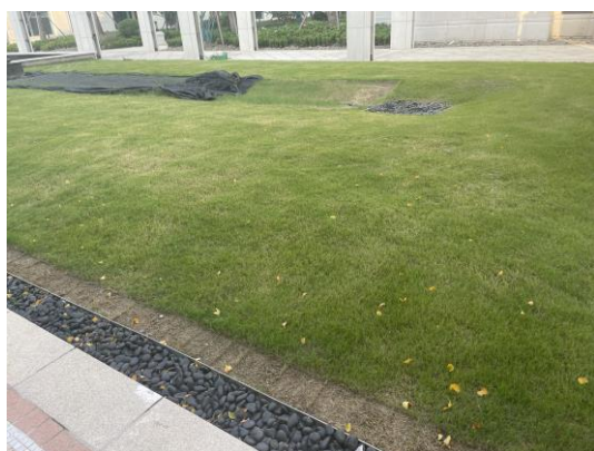
雨水回用设施
