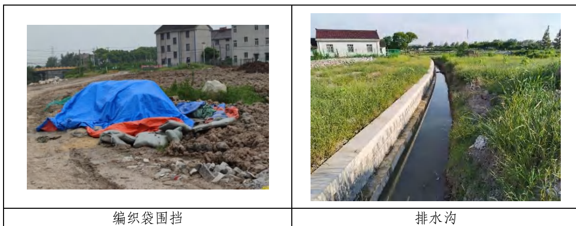
图4.3-1 临时措施实施情况
