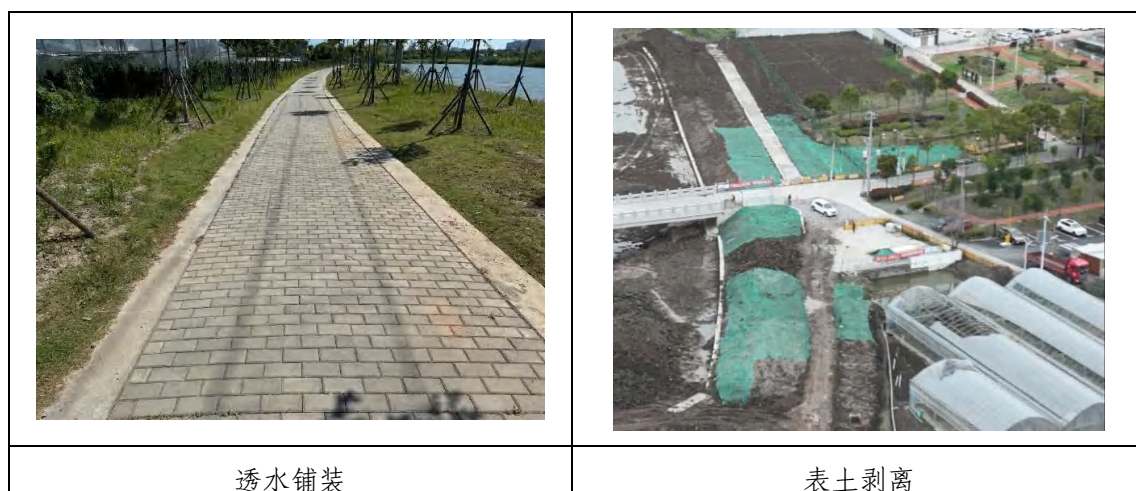
图4.1-1 工程措施实施情况
