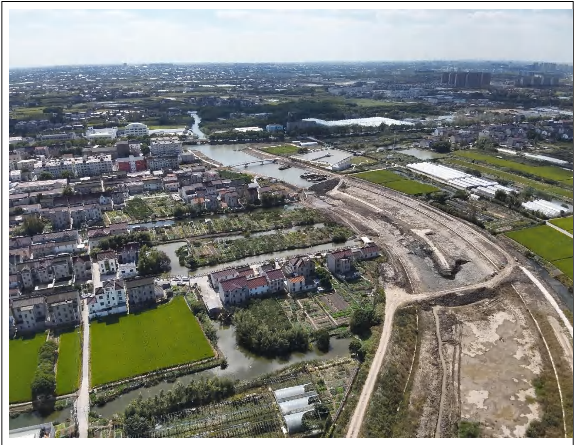
附图 4-2 项目区影像照片（施工中 2022 年 10 月）
