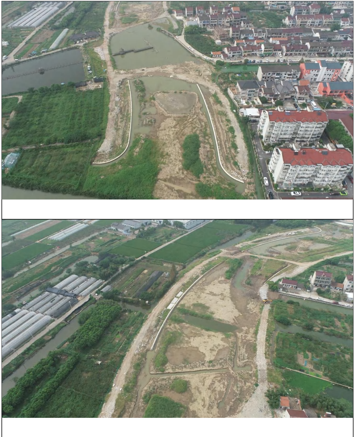
附图 4-1 项目区影像照片（施工中 2021 年 9 月）
