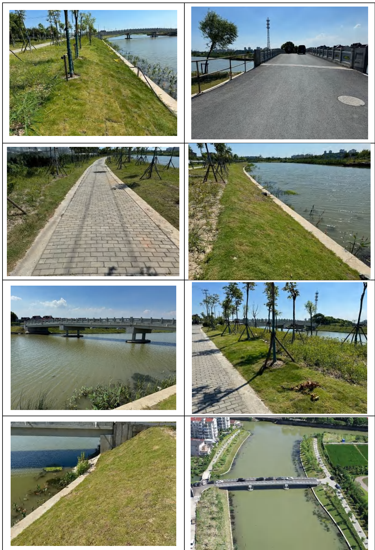
附图 3 重要水土保持设施现场验收照片
